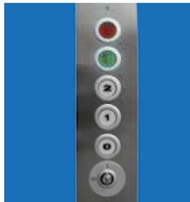
Boîtier de commande encastré au palier « envoi et appel », avec contact à clé et indicateur de présence aux étages.
