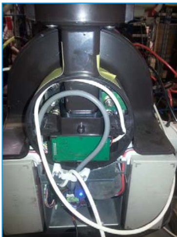
Figure 4-16: Batteries dans le monte-escalier
