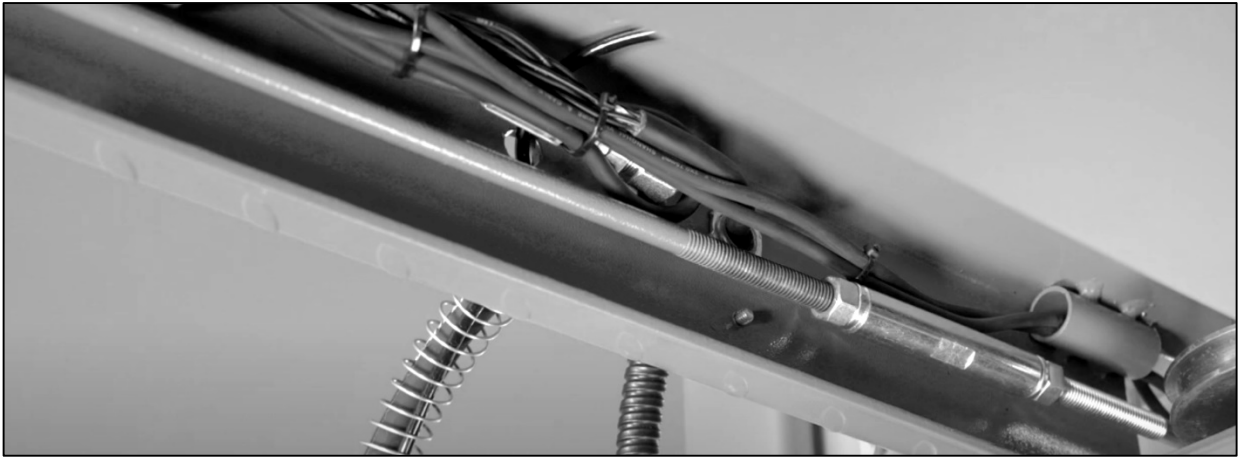
Figure : Câble sous la chaussée
