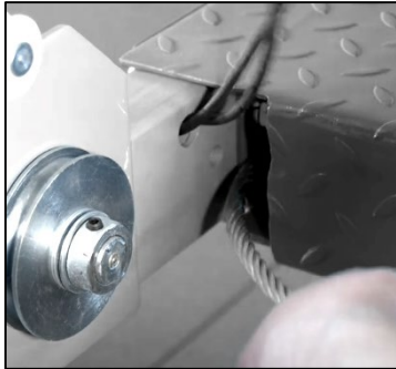
Figure : Pose des câbles d'acier
